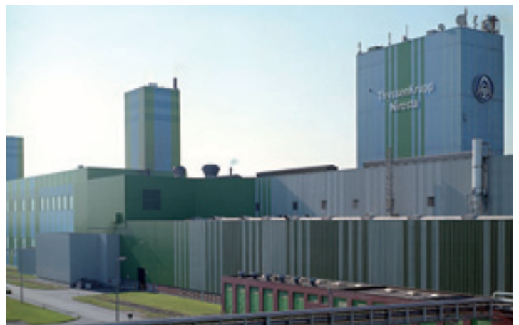
Das Werk der ThyssenKrupp Nirosta GmbH in Krefeld.
